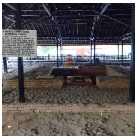
Gambar 12. Bangunan Taman Kepurbakalaan yang sudah bolong-bolong, terlihat lobang-lobang kecil yang berjumlah puluhan titik
