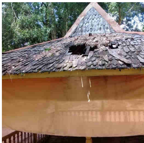
Gambar 6.b Bangunan pelindung sumur Telaga Darah
